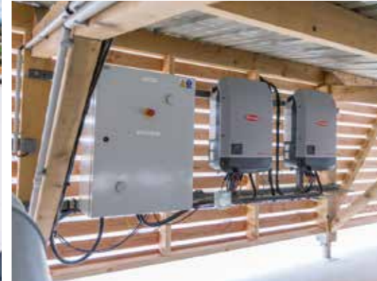
Système photovoltaïque : capteurs et onduleurs en toiture
