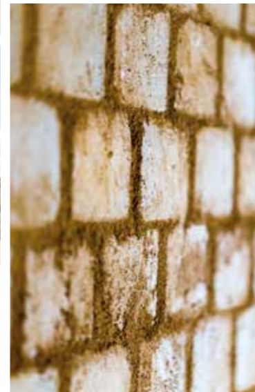
Montage du mur en briques de terre crue
