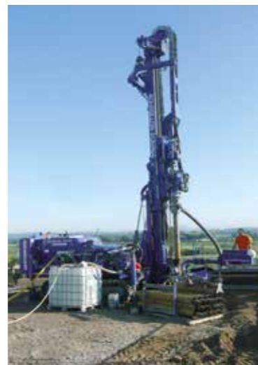
Forage des sondes géothermiques
