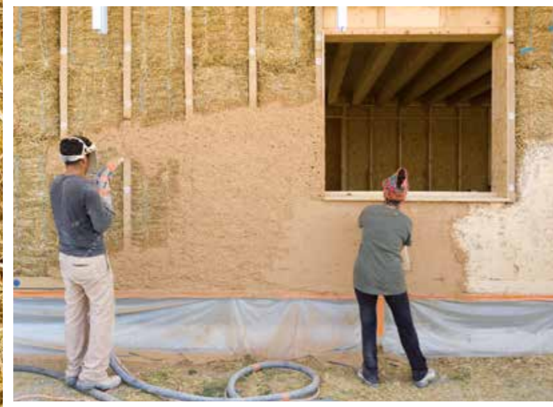
Projection de l'enduit extérieur en terre
