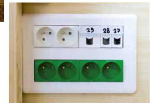
Bloc prises avec circuit "éco" coupe-veilles
