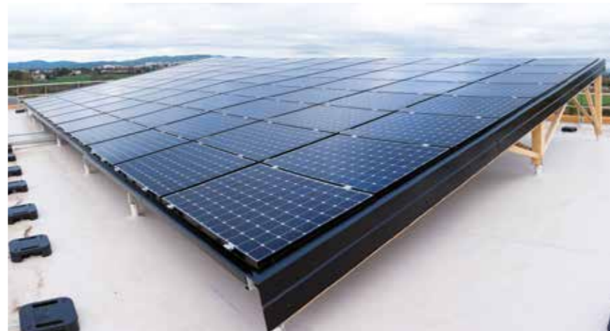
Système photovoltaïque : capteurs et onduleurs en toiture
